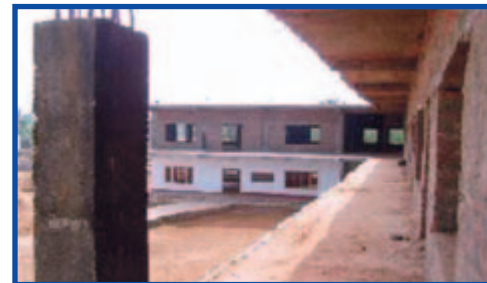
Die Aufstockung der Gebäude steht kurz vor dem Abschluss.
