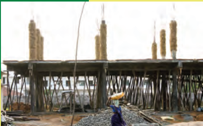
Die Baustelle der Sonderschule mitte Februar
