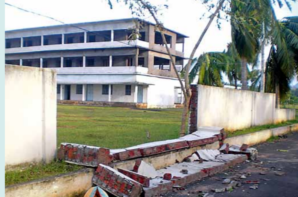
Abb. o.: Sogar eine Mauer fiel der zerstörerischen Kraft des Zyklons zum Opfer.
