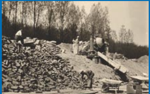
Bauarbeiten für das Mutterhaus beginnen
