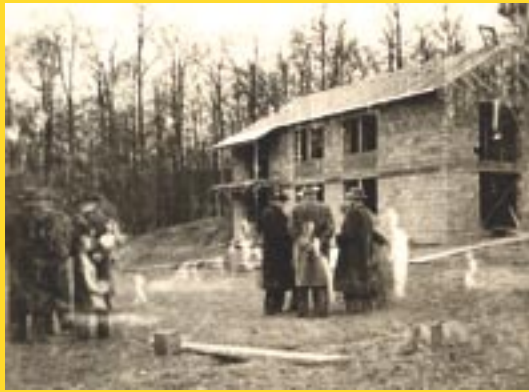
Erstes Richtfest auf dem Friedenshortgelände (für das Pfarrhaus).
