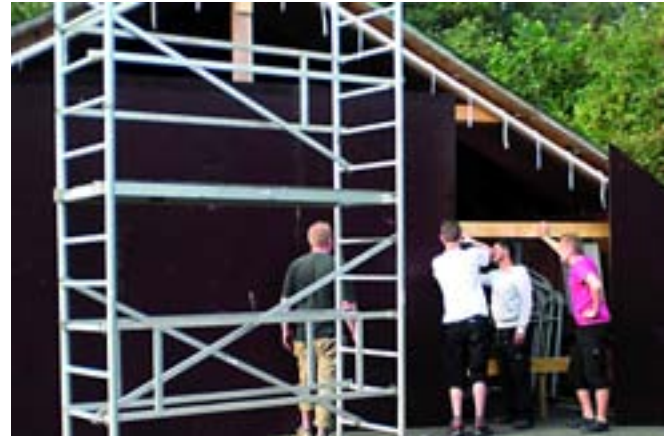
Die Gebäude wurden winterfest verschlossen.
