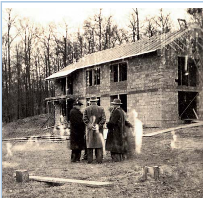
Erstes Richtfest auf dem Friedenshortgelände (für das Pfarrhaus).
