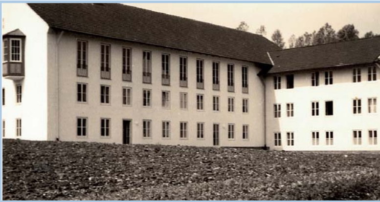
Ende 1956 ist der Neubau des Mutterhauses bereits gut vorangekommen.
