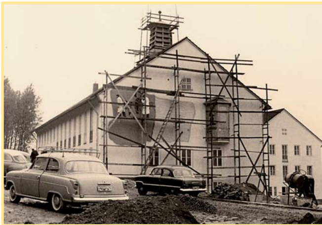
Das Sgraffito »Der Gute Hirte« entsteht.
