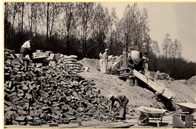
Die Bauarbeiten für das Mutterhaus beginnen.
