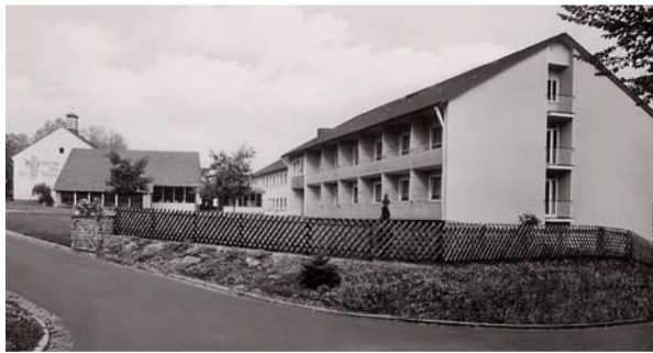
Als »Feierabendhaus« für die älteren Schwestern entsteht das Haus »Gottesruhe« (re.)
