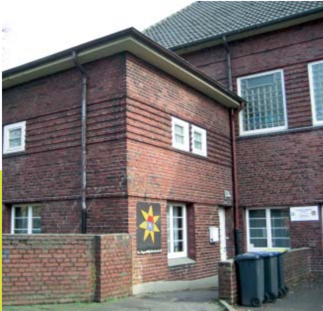
Dieses Backsteingebäude beherbergt nun die Einrichtungsleitung und das Büro für das Betreute Wohnen.
