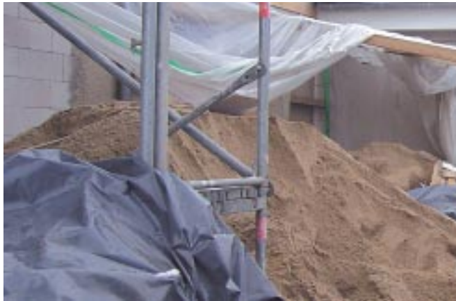
Auf der Baustelle Anfang März. Hier wird gerade der Estrich gemischt.
