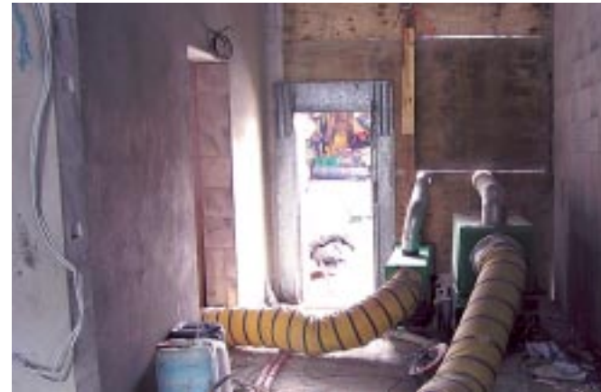
Nur durch die Bauheizung konnte im Winter weitergearbeitet werden.
