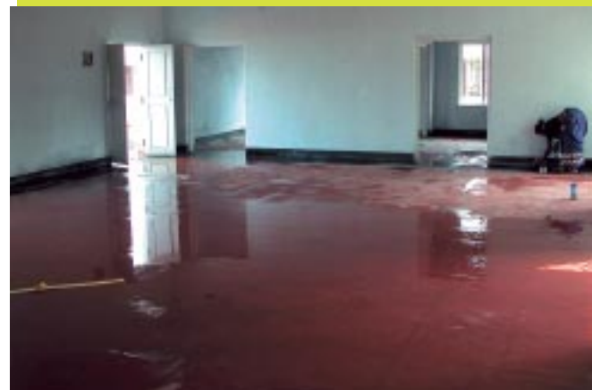
Die Häuser waren im Dezember im Rohbau fertig; um den Beton vor Rissen zu schützen, werden die Räume permanent gewässert.
